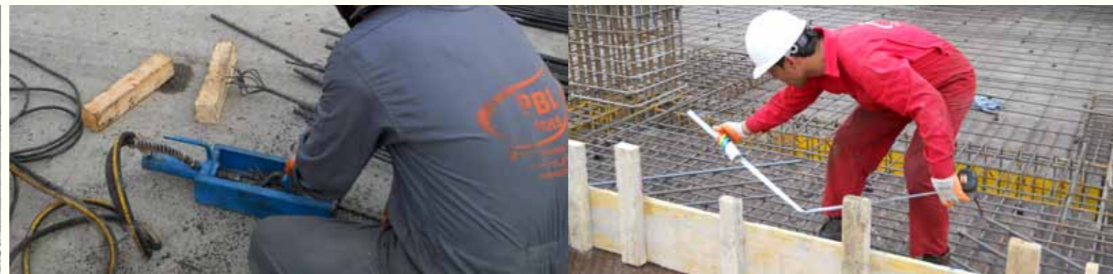
ایجاد سر مرده با روش بسکت یا پیازی در روش چسبیده
