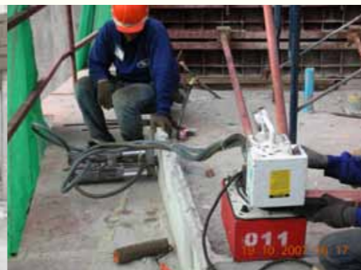
روش صحیح جایگیری اپراتورها هنگام کشش
