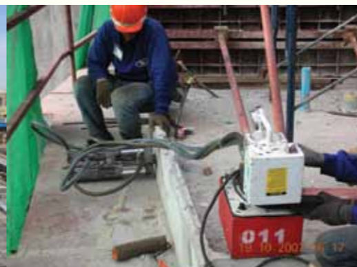
اعمال تنش به سقف
