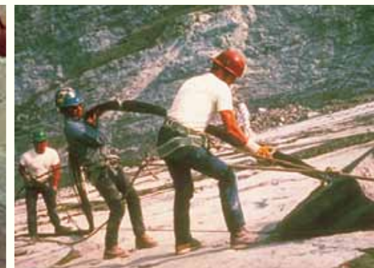
عملیات تحکیم خاک
