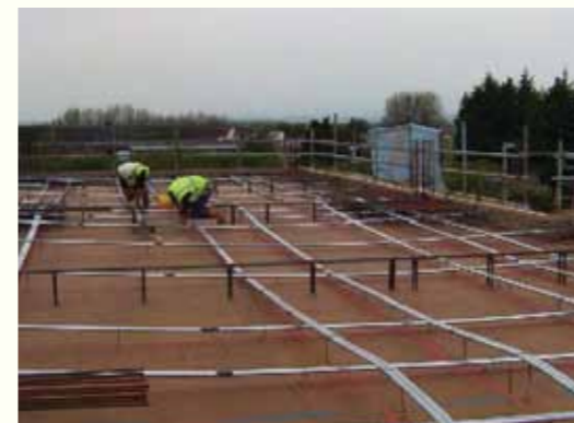
جانمایی تاندون های با رنگ آمیزی روی قالب
