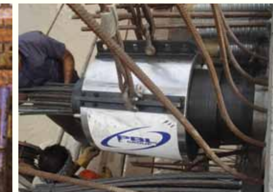
جک مولتی استرند - پروژه پل تله زنگ
