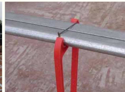
جانمایی تاندون ها با استفاده از اسپیسر های رنگی
