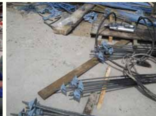
نصب انکوريج سرمرده در روش غیر چسبنده
