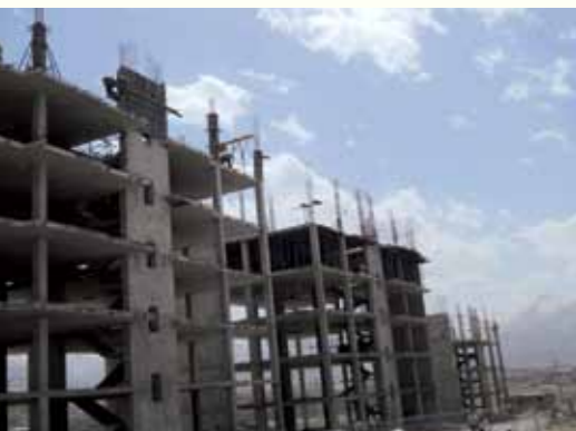
سقف های با ضخامت کم، بدون تیر پروژه مجتمع مسکونی همدان
