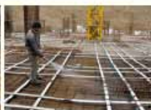
۱۷ شستدوی قالب به منظور ایجاد سقف صیقلی بدون نیاز به کف سازی
