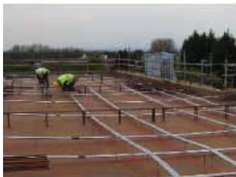
چلمبایی تاندون های بارنگ آمیزی روی قالب
