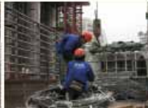
۶ حلقه کردن و حمل تاندون ها به سقف آماده
