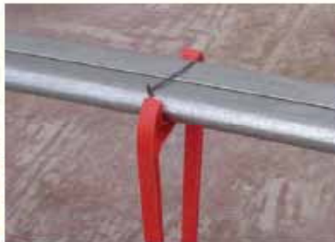
چلمبایی تاندون ها با استفاده از اسپیسر های رنگی
