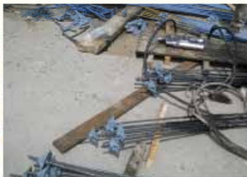
اصب انکوريج سرمرده در روش تیر چسبیده
