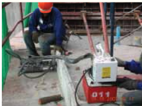
روش صحیح جایگیری اپراتورها هنگام کشش
